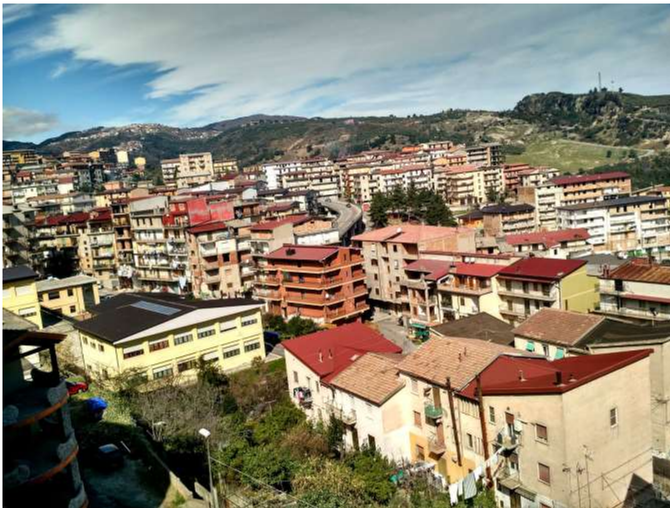
Il plesso scolastico di v.D.Alighieri, sullo sfondo il quartiere di “Colla”, con gravi problemi idrogeologici e di abusivismo edilizio.
